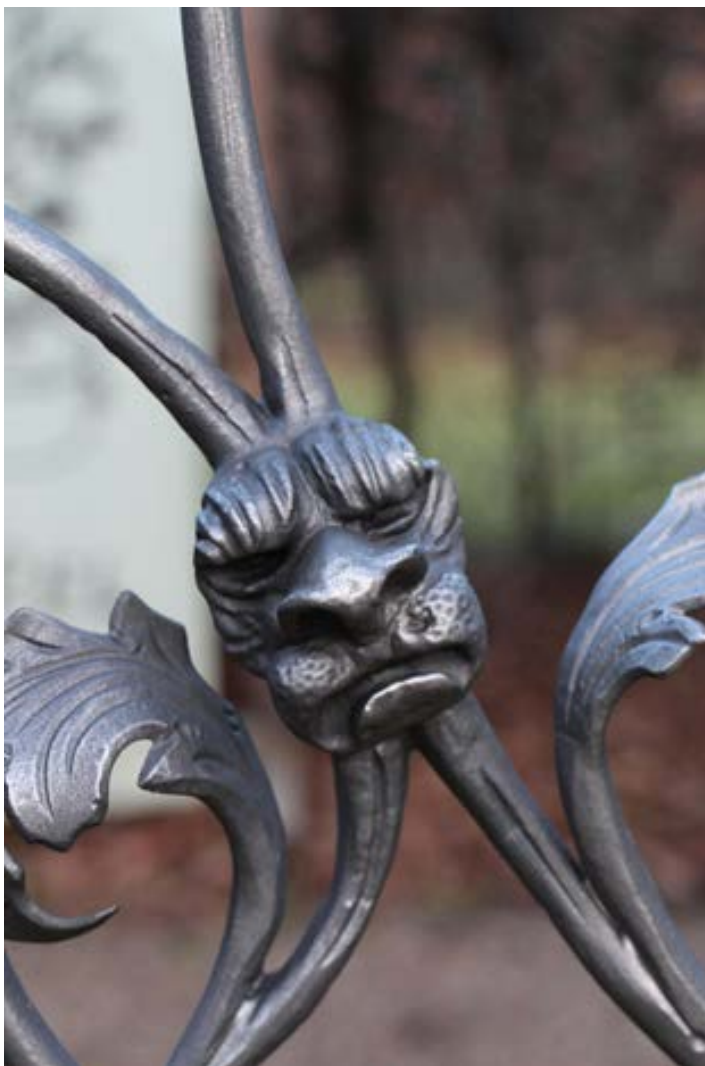
Detail výzdoby jihovýchodní dvoukřídlé kované renesanční branky, ohradní zeď Zámku Troja. Stav po restaurování
