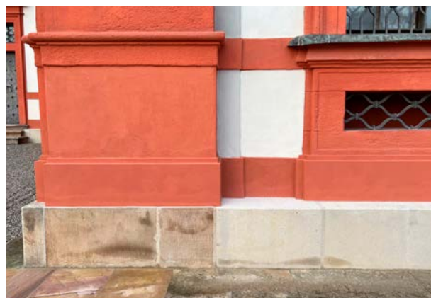
Stav soklu po dokončení restaurátorských prací
