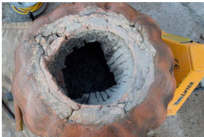
Průběh restaurátorských prací; odstraňování betonové výplně z těla vázy, detail
