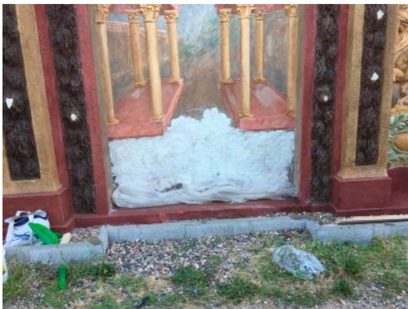
Odsolovací zábal, průběh restaurátorských prací, středová partie prospektu, detail.
