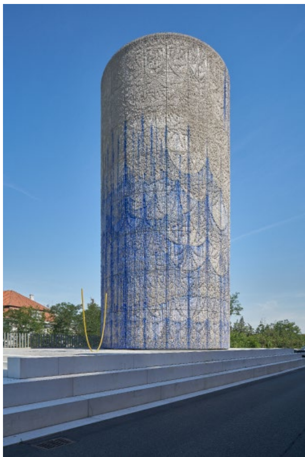
Obkladové panely tubusu výdechu tunelu Blanka, Federico Díaz, Letná, Praha 7, foto Jan Kuděj
