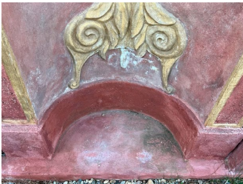
Východní prospekt s Herkulovými činy. Solné výkvěty, výskyt řas, poškozená barevná úprava prospektu; detail
