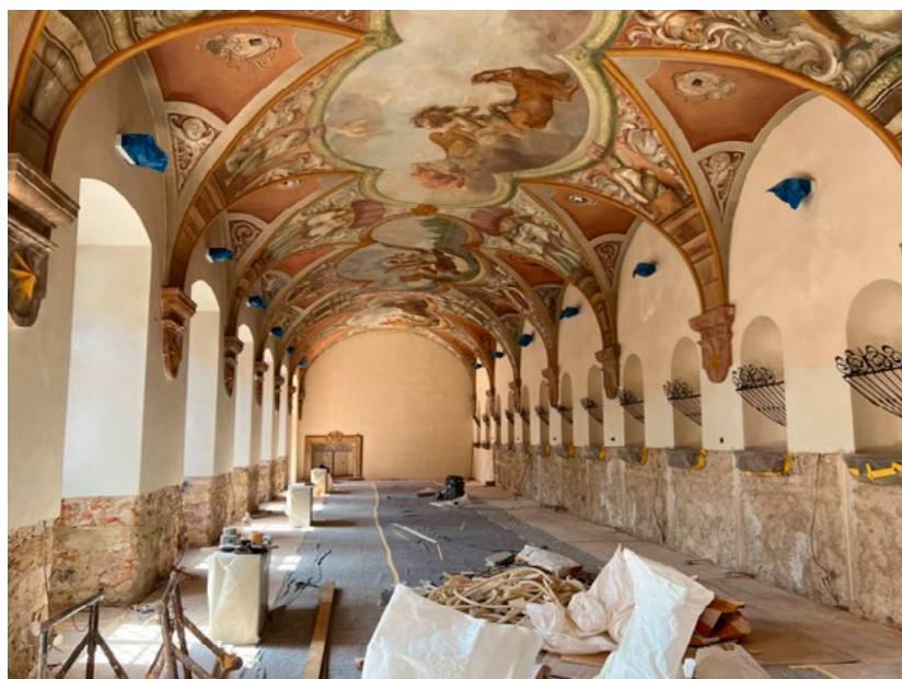
Levá hospodářská budova, konírna, stav po lokálním otlučení zasolených omítek, severní a jižní stěna. Zhotovitel SPAK – SF s.r.o., Ing. M. Kraus. Calling, Inner Fields, Praha 8, foto Petr Kopal
