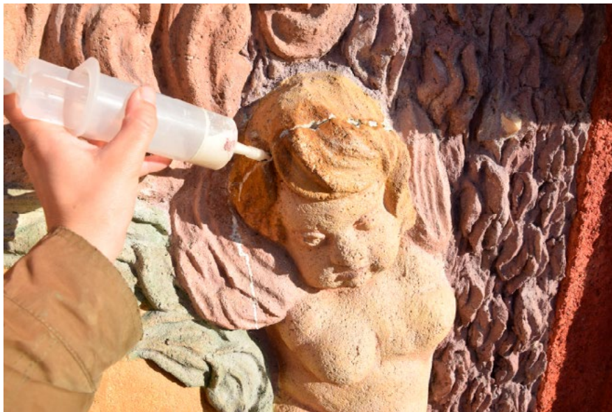
Zajišťování trhliny u plastické výzdoby severního prospektu, reliéfní figurální štuková výzdoba s erbem Kláry Bernardiny z Malzanu, pravá strana prospektu, průběh prací, detail.
