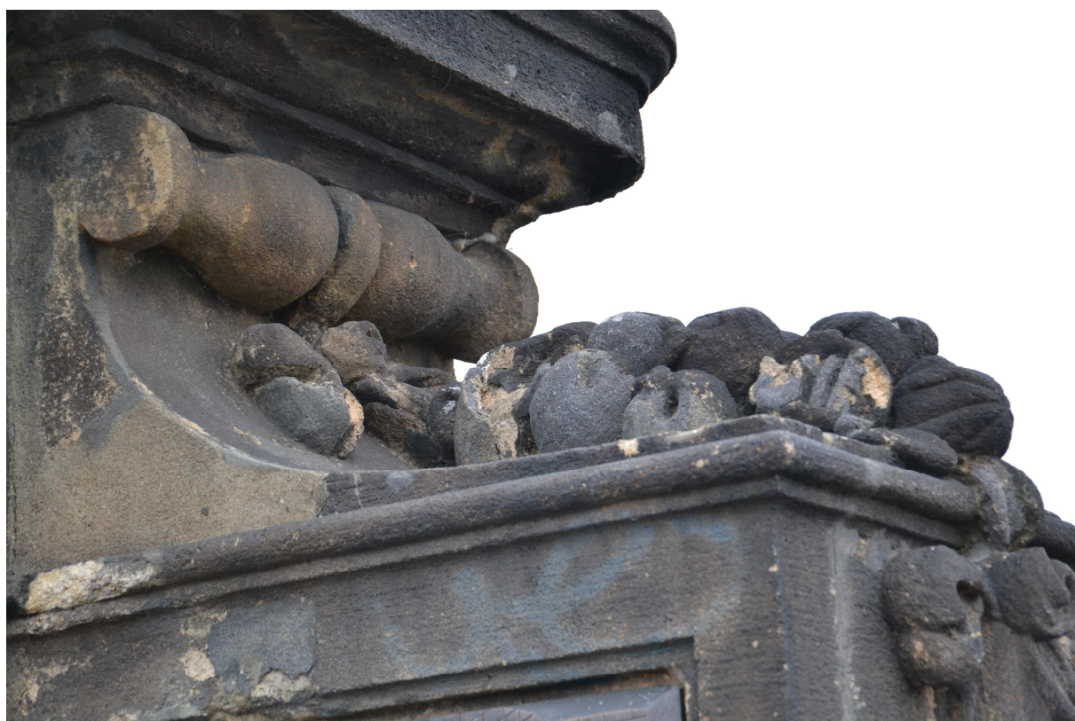
Koroze kamene, spárování a doplňků v tmelu, detail
