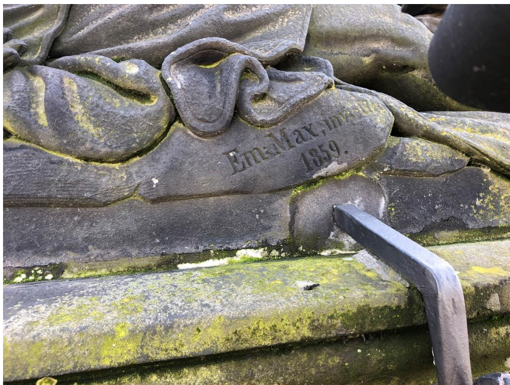
Sousoší Piety od Emanuela Maxe na Karlově mostě, detail uchycení kovové lucerny
