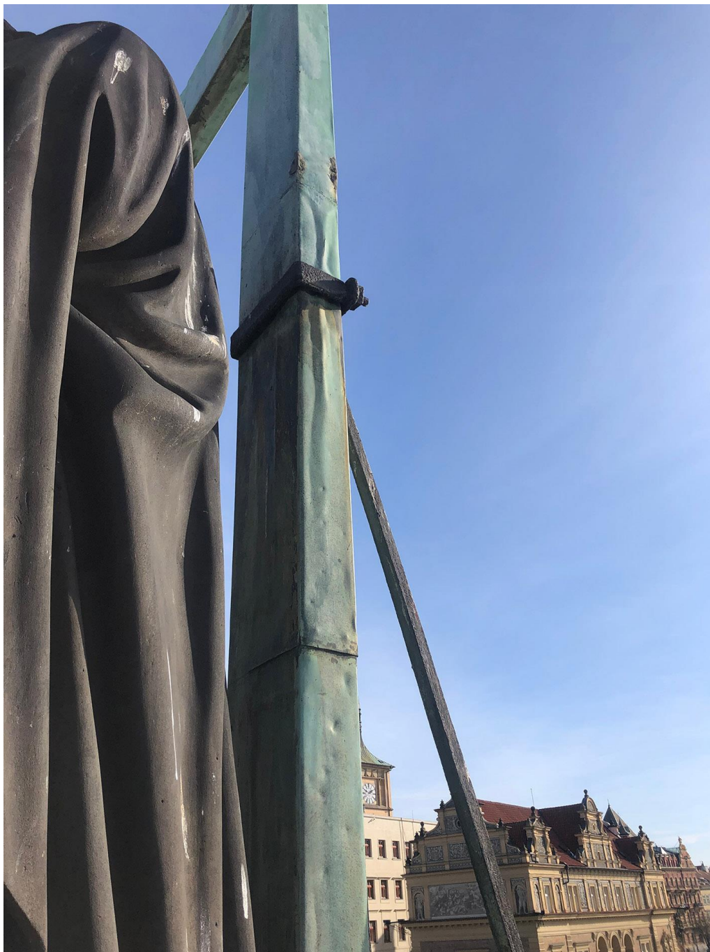
Sousoší Piety od Emanuela Maxe na Karlově mostě, detail poškození měděného kříže
