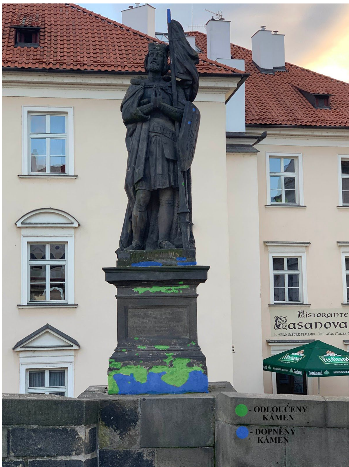
Druh poškození a povrchové doplnění je obdobné ze všech stran sochy
