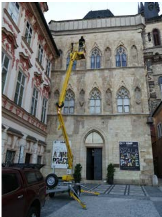
Doplňkový restaurátorský průzkum z plošiny před zahájením restaurátorských prací. Ak. soch. J. Plachý
