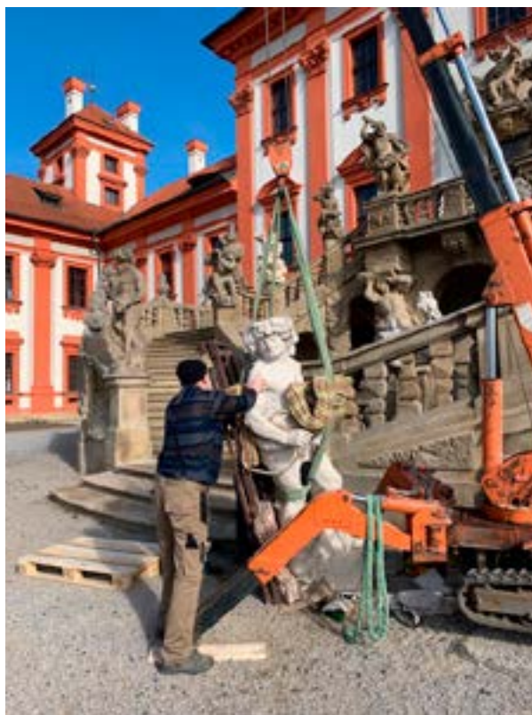
Hlavní schodiště Zámku Troja, osazování poslední sekané kopie; Bakchus, dolní podesta, průběh prací. Restaurátor: ak. soch. V. Adamec
