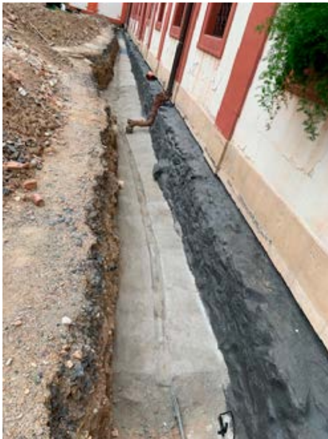
Drenážní systém, levá hospodářská budova. Průběh prací. Fy SPAK – SF s.r.o.
