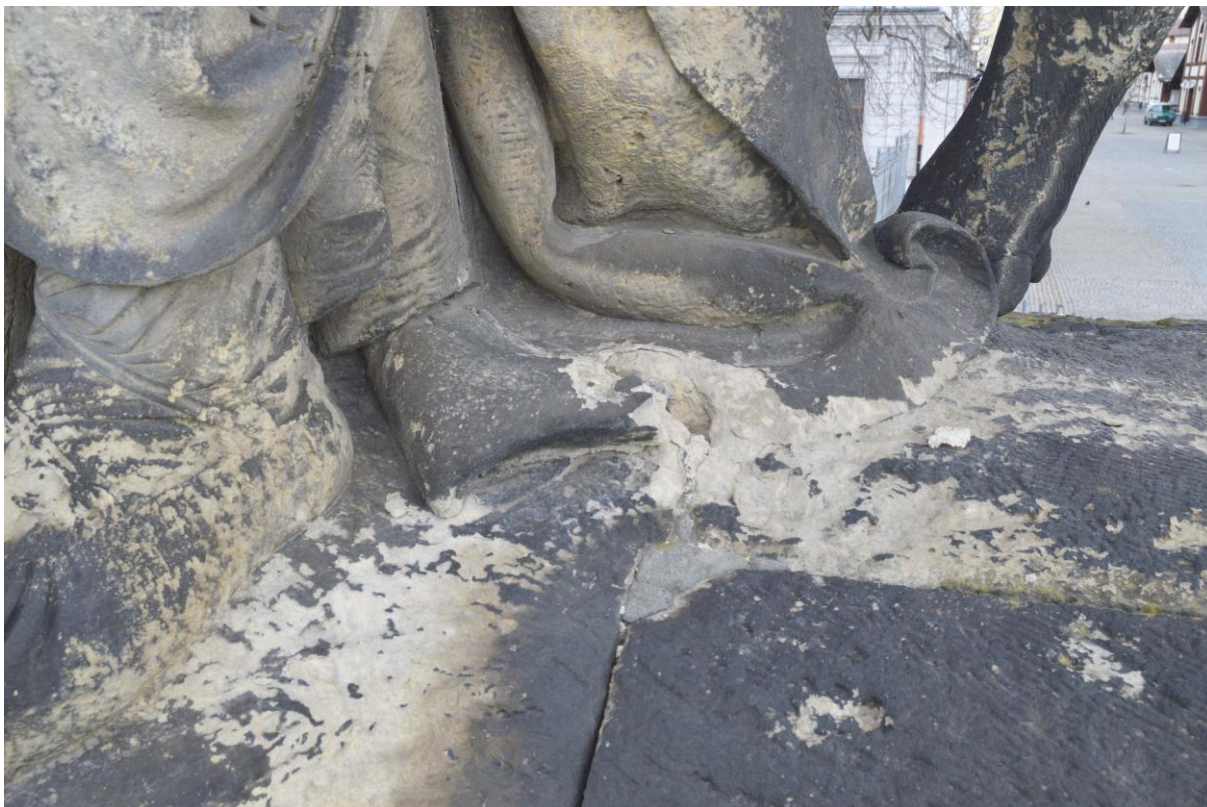
9. detail plintu s poškozenou draperií a spárováním
