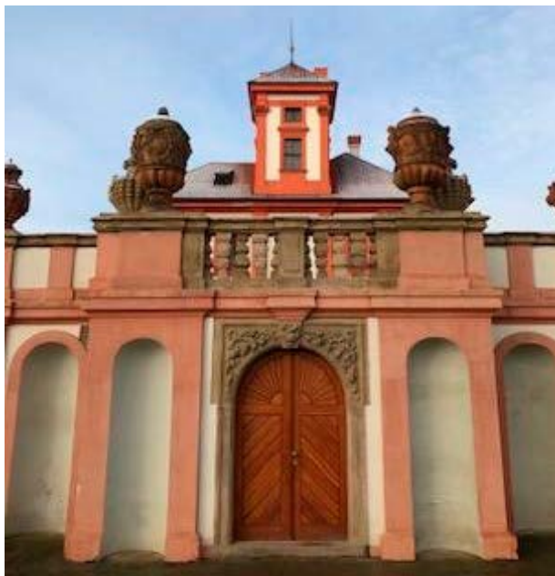
Vstupní portál do vinných sklepů po restaurování; terasové zdi, východ.
