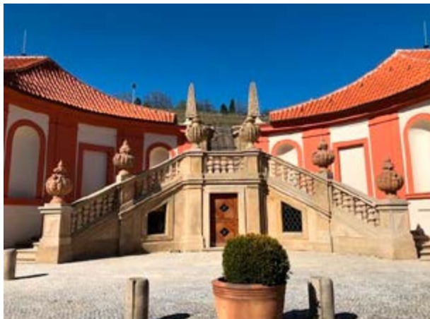
Malé zahradní schodiště, stav po dokončení stavebních a restaurátorských prací
