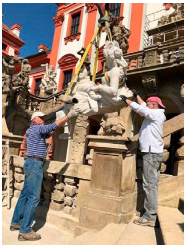
Hlavní schodiště Trojského zámku, osazování kopie Ceres, dolní podesta
