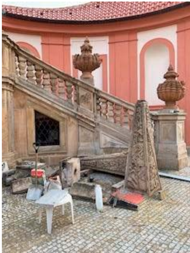
Malé zahradní schodiště, Zámek Troja, stav v průběhu dokončovacích restaurátorských prací
