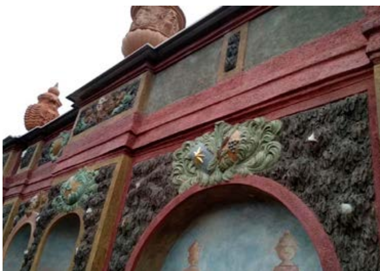
Východní prospekt s Herkulovými činy, osazená okapnička na koruně zdi
