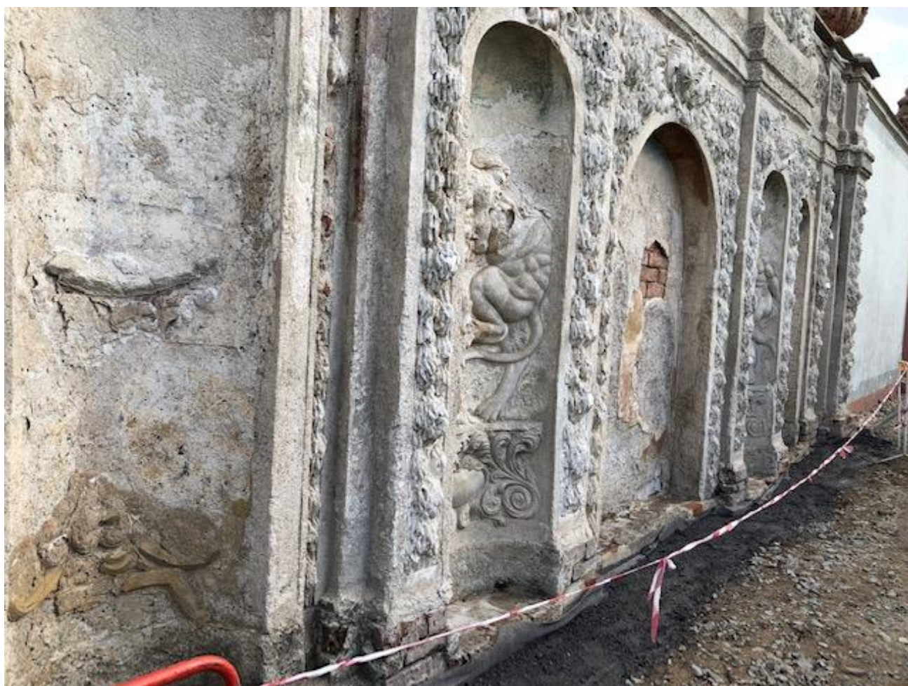
Východní opěrná zeď Trojského zámku, výsek, prospekt s Herkulovými činy foto v průběhu prací na stavebním odvlhčení zdi Stavební část Ing. Kraus, SPAK – SF s.r.o.; restaurátorská část Brandl s.r.o.
