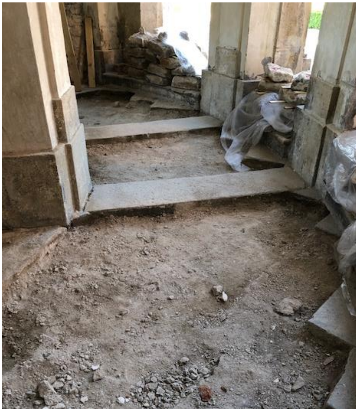
Hlavní vnější barokní schodiště Trojského zámku, rozebírání pískovcové dlažby podesty pod rameny schodiště
