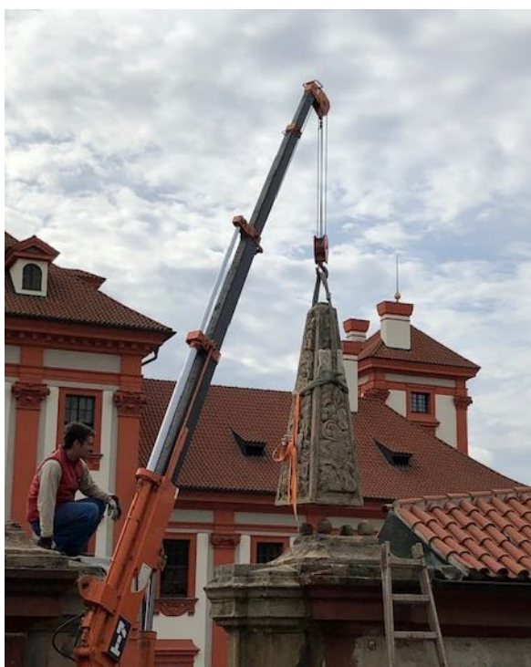
Snímání obelisků ze vstupního portálu schodiště theatronu, průběh prací
