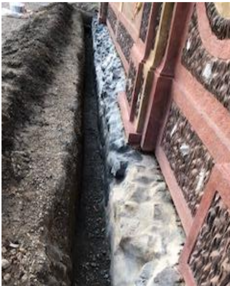
Detail stavební rýhy, minerální stěrka, průběh stavebních prací
