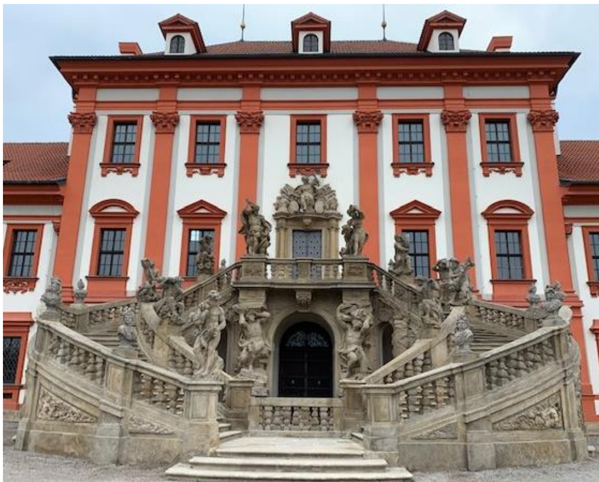
Hlavní schodiště trojského zámku, stav před dokončovacími pracemi
