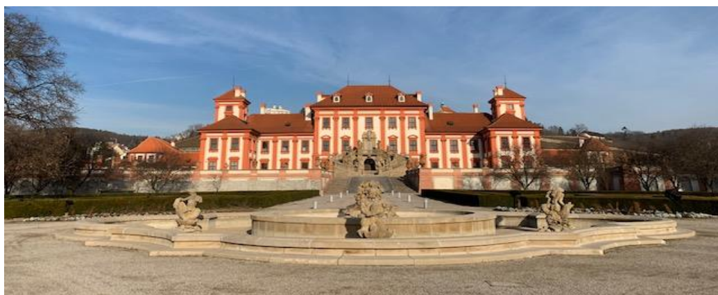
Neptunova kašna po očištění a obnově spárování, celkový pohled od jihu
