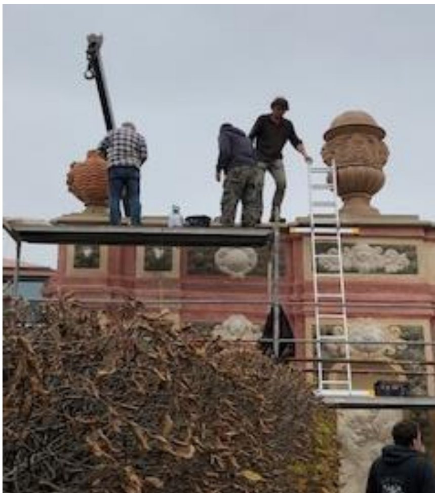
Východní prospekt s Herkulovými činy, průběh prací, osazování váz na korunu zdi
