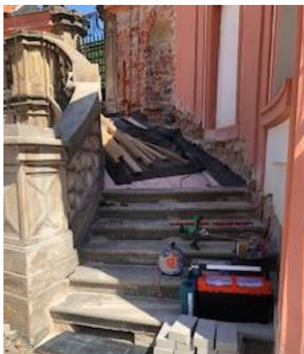
Theatron, osazování schodišťových stupňů, průběh prací
